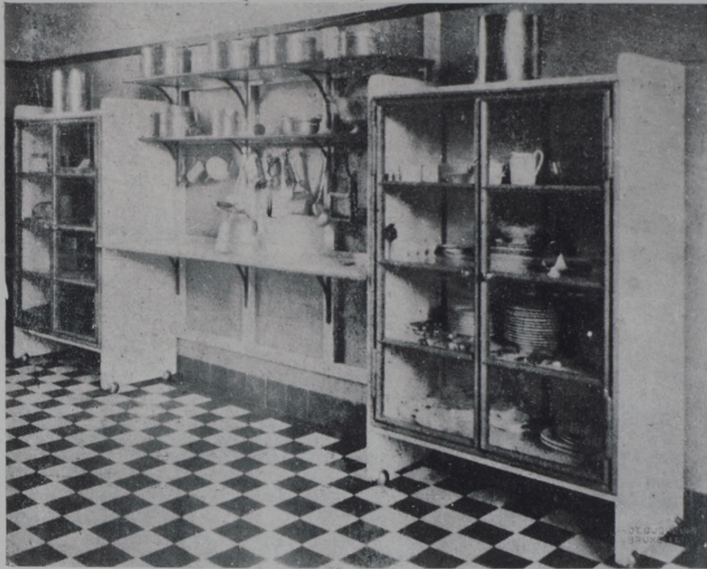
CUISINE 1921. COLLABORATION ET EXECUTION PAR LA FIRME VAN HAMME, BRUXELLES
