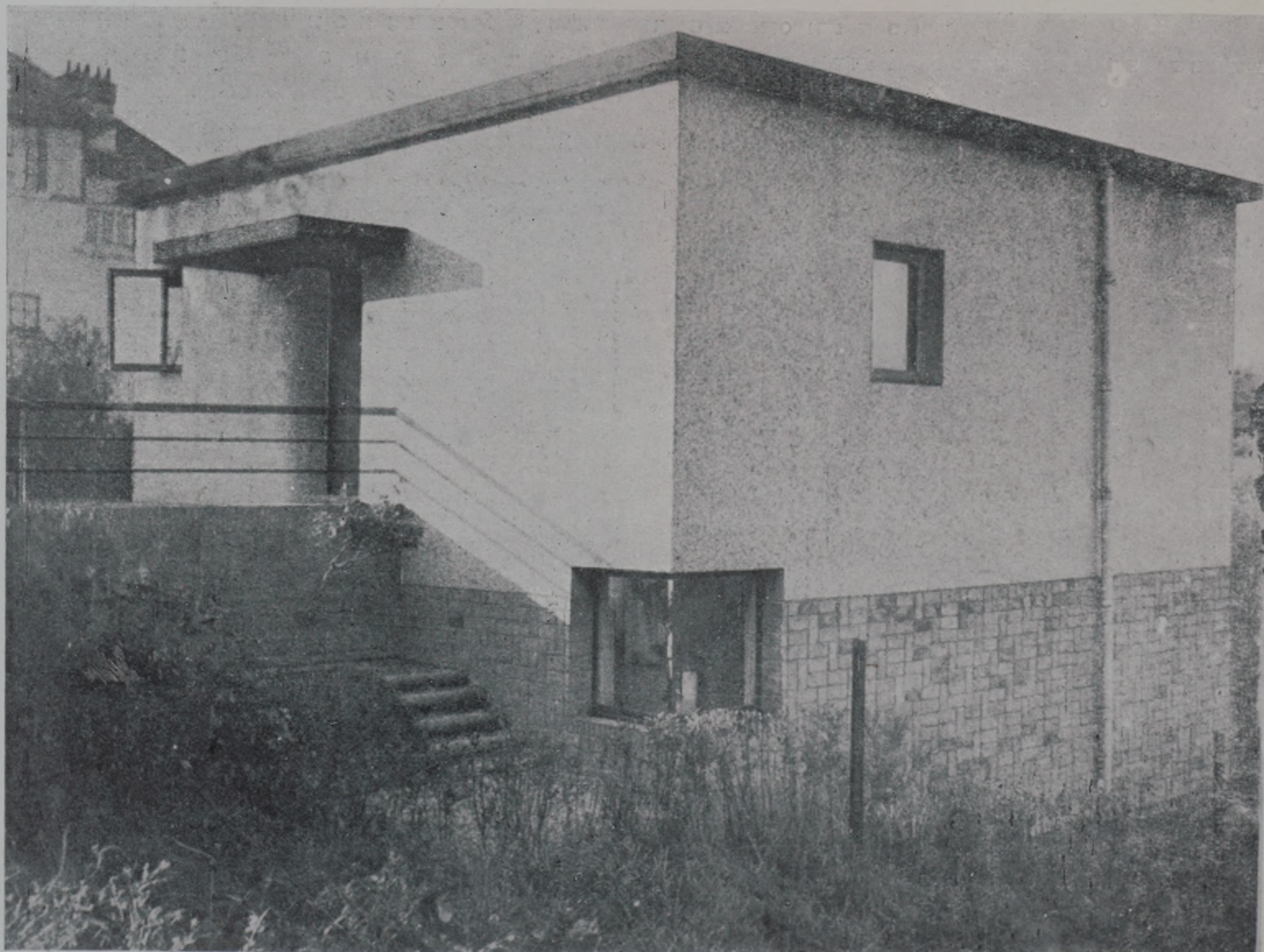
PROPRIETE SISE A UCCLE-BRUXELLES, 49, AVENUE FOND'ROY. ARCHITECTE : L.-H. DE KONINCK. 1924.
